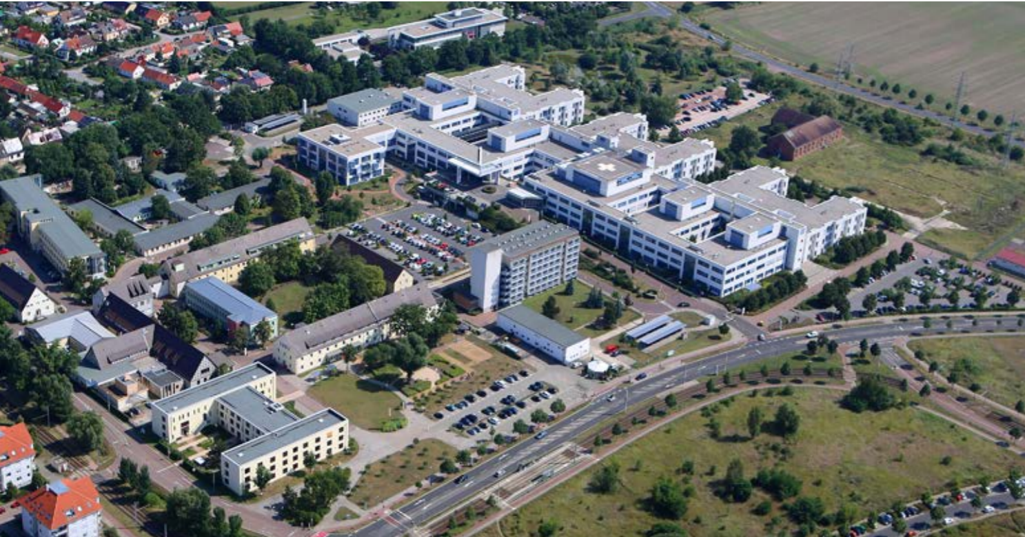
Blick aus der Vogelperspektive: Links das MVZ, rechts das 2011 fertiggestellte Städtische Klinikum.
