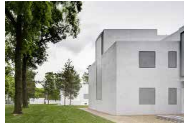
Das neue Meisterhaus Moholy-Nagy, Bruno Fioretti Marquez Architekten, 2010-2014
